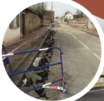
Enfouissement des réseaux rue des Fossés
