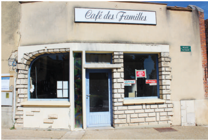
1 Place Saint-Macé, anciennement le « Café des Familles » avant travaux
