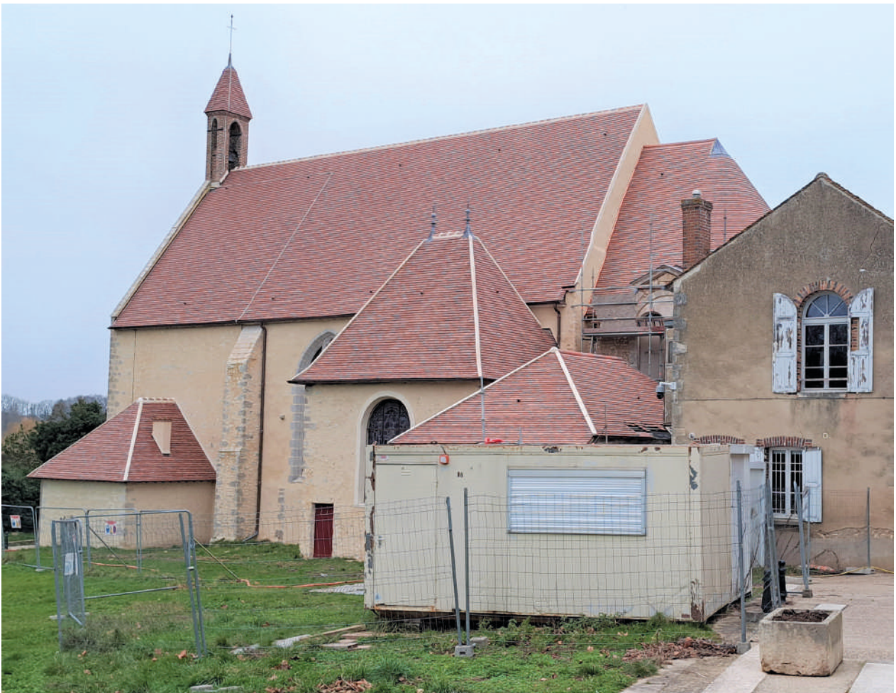
Église Notre-Dame de Bethléem en cours de travaux
