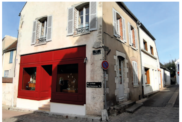
15 rue du Lion d'Or après travaux
