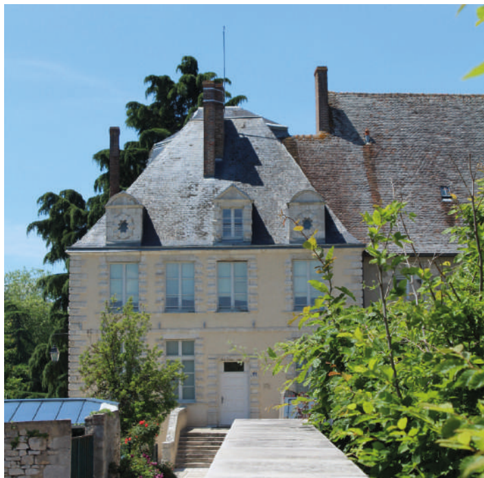
Façade et toiture du Pavillon Louis XIII
