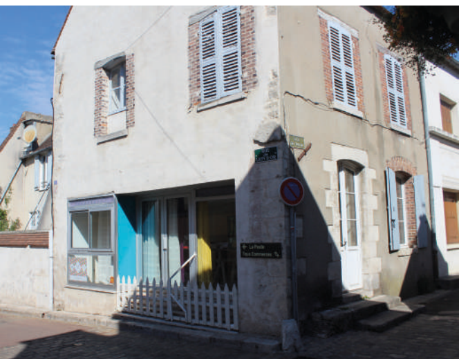
15 rue du Lion d'Or avant travaux
