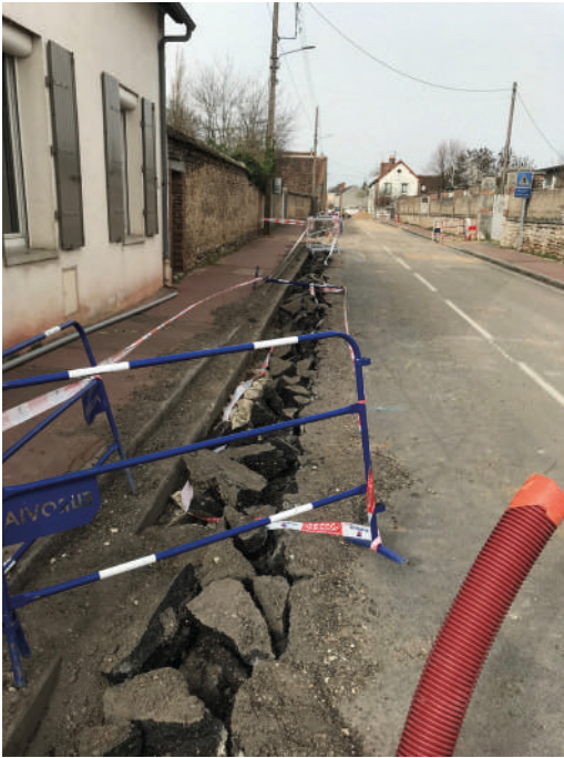
Enfouissement des réseaux rue des Fossés
