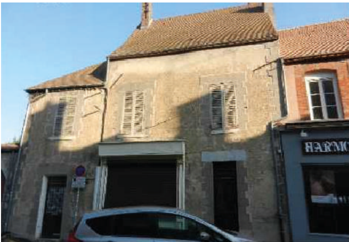
Façade 7 Grande Rue état existant
