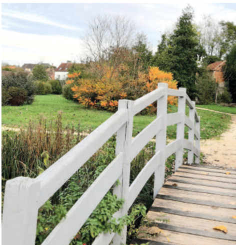
Pont de la Peupleraie
