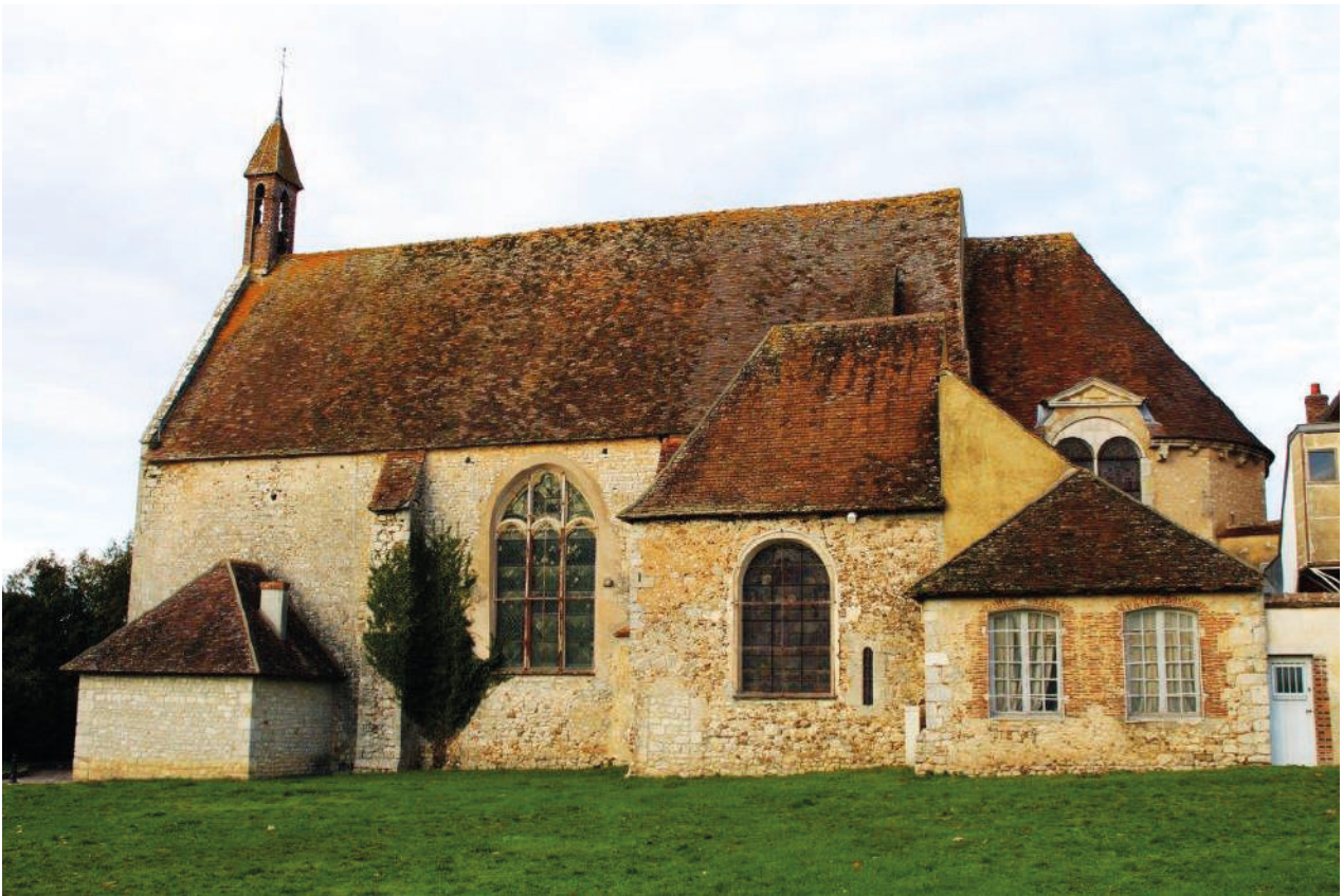
Église Notre-Dame de Bethléem avant travaux
