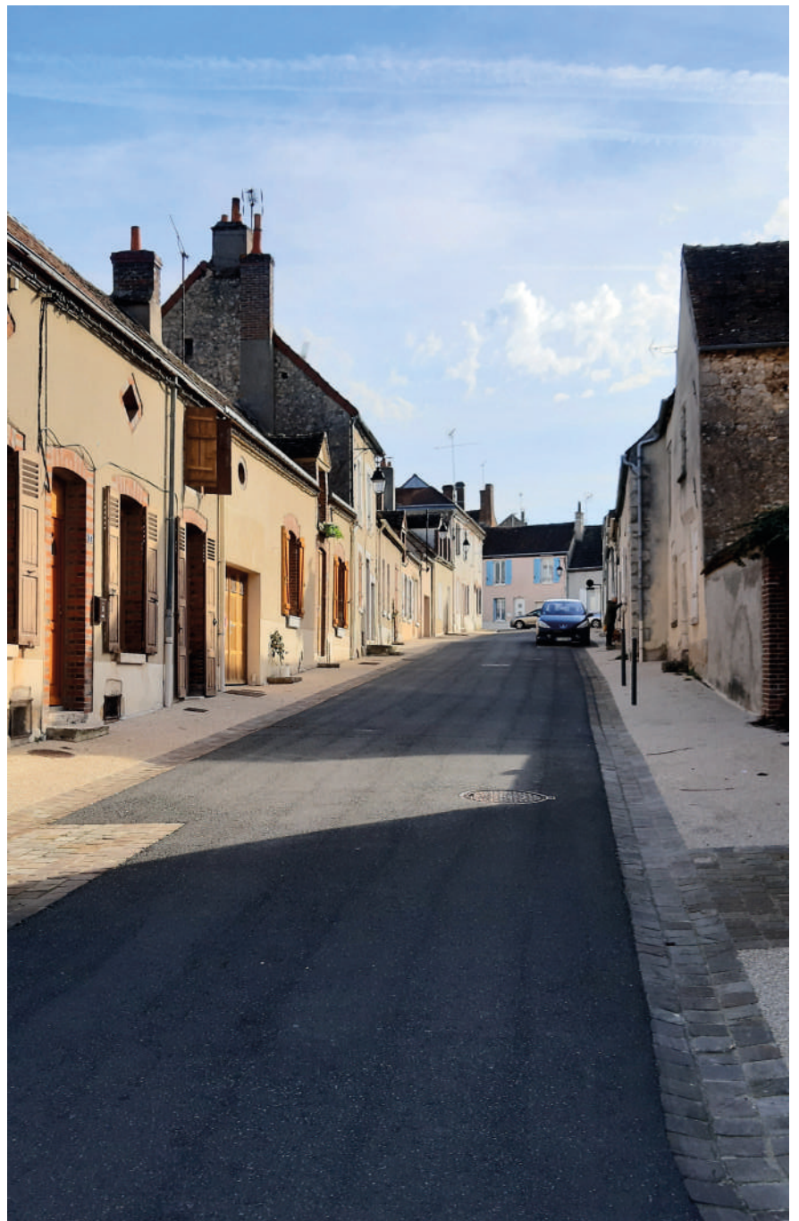
Rue des Vieilles Halles après travaux
