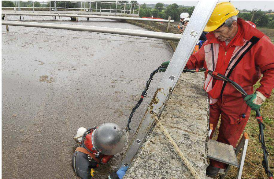
Intervention dans le bassin d'une usine
