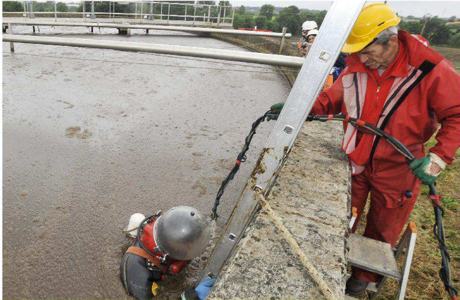
Intervention dans le bassin d'une usine
